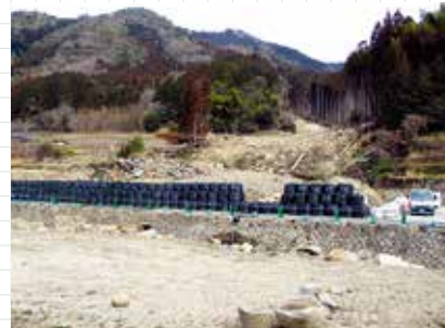
社屋から100m程度上流の山腹崩壊箇所。 ここから土砂・流木が下流に流出
