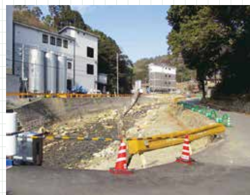
社屋前の河川。社屋前の橋が流木等で詰まりダム化
