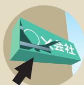
パネル板の破損
