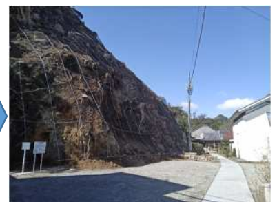
〔法面からの落石を防ぐための工事をしました
