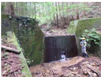
〔既設治山施設の点検状況〕
