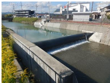
農業水利施設の更新整備（青木頭首工）
