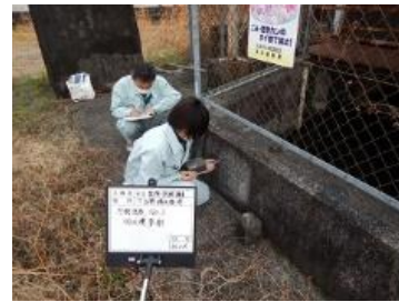
農業水利施設の監視診断調査（大井川用水）
