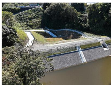
ため池の耐震整備 (ため池群萩間川地区) (土沢池)
