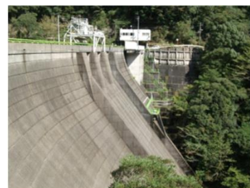
管理設備の更新 (大代地区) (大代川農地防災ダム)
