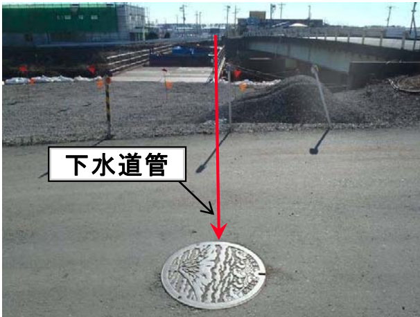
下水管経路 北側から南側を望む
