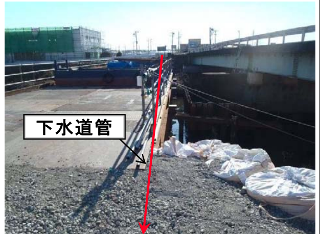
下水管経路 北側から南側を望む
