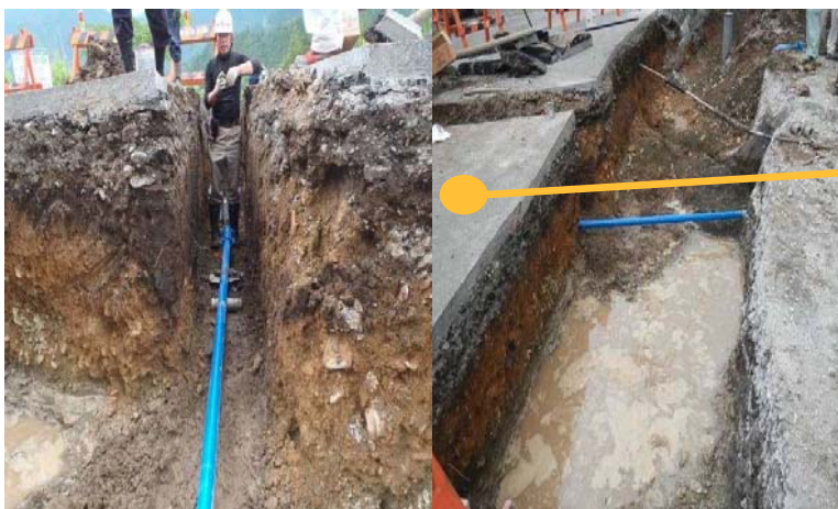
③復旧完了
