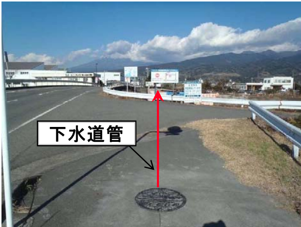
下水管経路 南側から北側を望む
