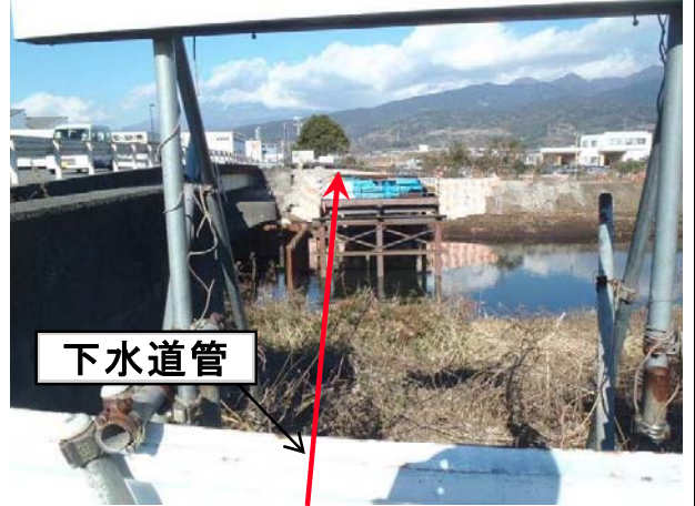
下水管経路 南側から北側を望む
