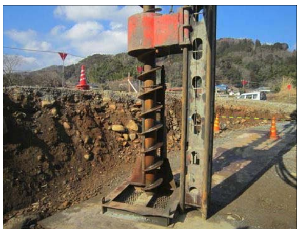
(写-4) 固定架台 (固定状況)
