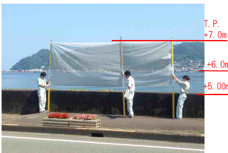
T. P. +7. 0m (L1-2m) 壁高2. 90m (既設胸壁 約T. P. +5. 0m 壁高約90cm)
