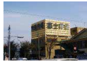
屋上広告の背景色が高彩度で目立つ色彩となっている。
