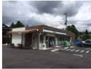
景観に配慮した白糸の滝周辺の店舗改修
