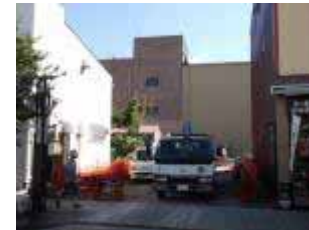
店舗併用住宅の建設現場(H25年度当初)
