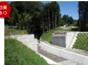
周辺景観に馴染むよう護岸の土のうを植生土のうとした。(H24年度)
