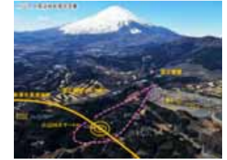
(仮称)小山パーキングエリア周辺地区現況
