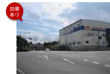
新設された建築物の壁面広告は基準に適合している。(H25年度末)
