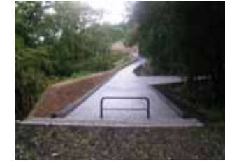
連絡通路完成後の様子(H27年度末)
