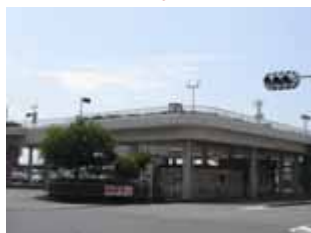
ペDESTリアンデッキの塗装補修 (H25年度末)
