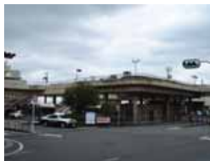
老朽化したペDESTリアンデッキ (H25年度当初)
