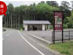
駐車場・休憩所トイレの整備完了。案内標識も景観に配慮したものとす。(H27年度)
