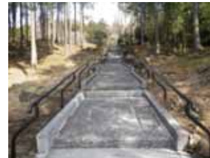
景観に配慮した手摺の整備(H27年度末)
