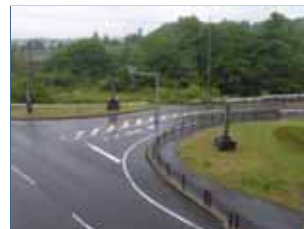
ガードレールは白、ガードパイプは茶、色が統一されていない。(H27年度当初)
