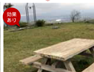
新たなベンチを設置(H27年度中間)
