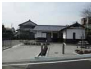
施設整備(トイレ)整備後(H25年度末)
