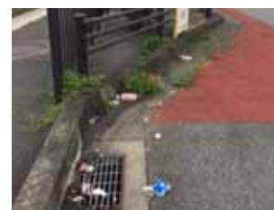
道路沿道にゴミ・雑草が多い。
