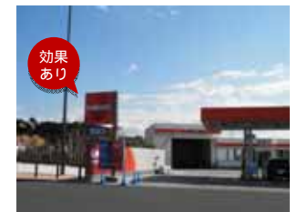
NEXCOの協力により、ガソリンスタンドの広告塔を建物の高さに合わせて改修(H25年度末)
