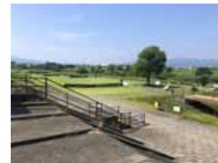
管理用道路はインターロッキング及びアスファルト舗装で整備されている。
