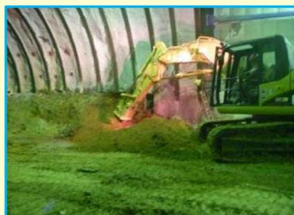
②ツインヘッドによる下半掘削状況
