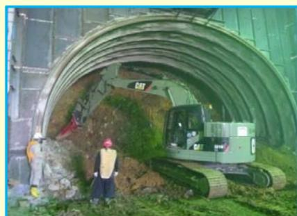
①ブレーカーによる上半掘削状況
