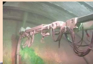
吹付ノズル先端の様子⇒ ノズルの向きは、 リモコンで操作します。
