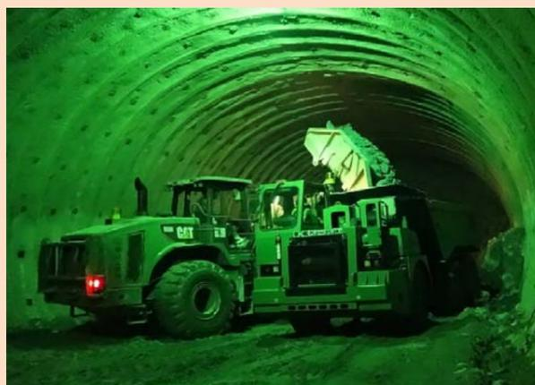
トンネル坑内でのズリ積み込み状況
