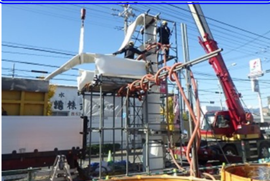
管状の更生材料の挿入状況
