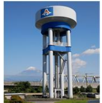
富士川浄水場サージタンク
