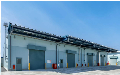
株式会社天野回漕店 流通元町2号倉庫
