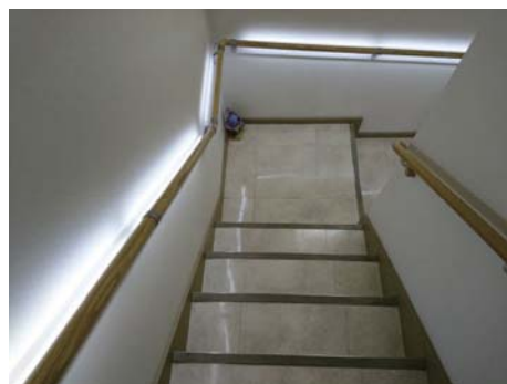
▲病院内の施工事例
