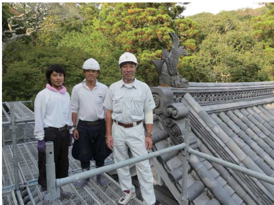
▲重要文化財 袋井市油山寺 山門瓦葺工事
