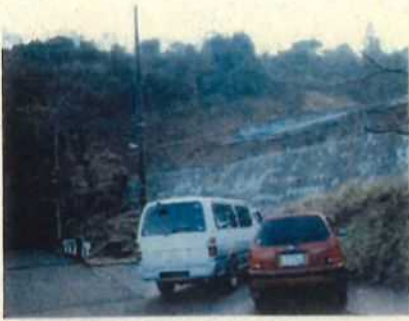
既設擁壁状況
