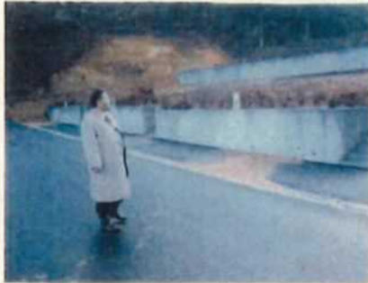
⑨ 擁壁状況
