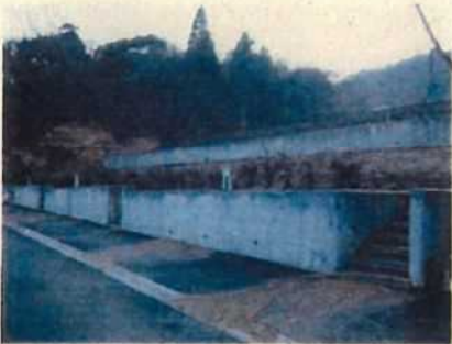
⑪ 擁壁状況
