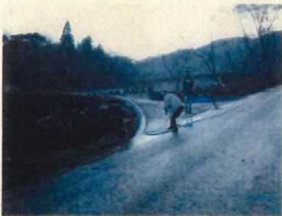
⑫ 市道の接道部
