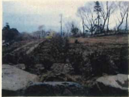
⑪ 仮防災施設
