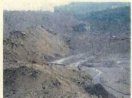
③ 盛土状況
