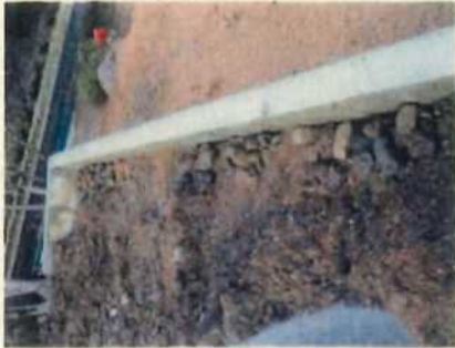
⑧ 擁壁背面状況
