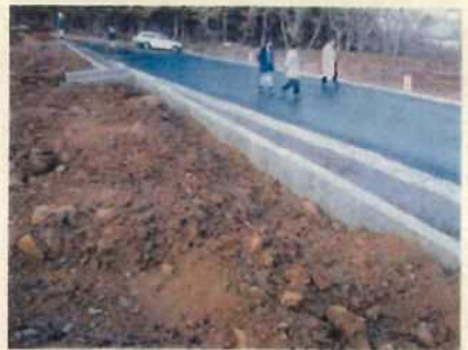
⑥ 擁壁背面状況
