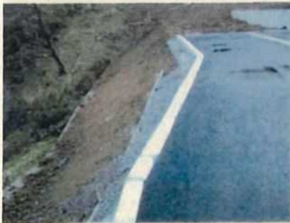
擁壁上部盛土状況
