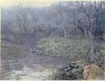
④ 掘削状況
