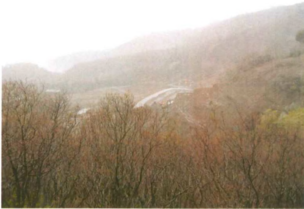
区域外から D 工区を望む
