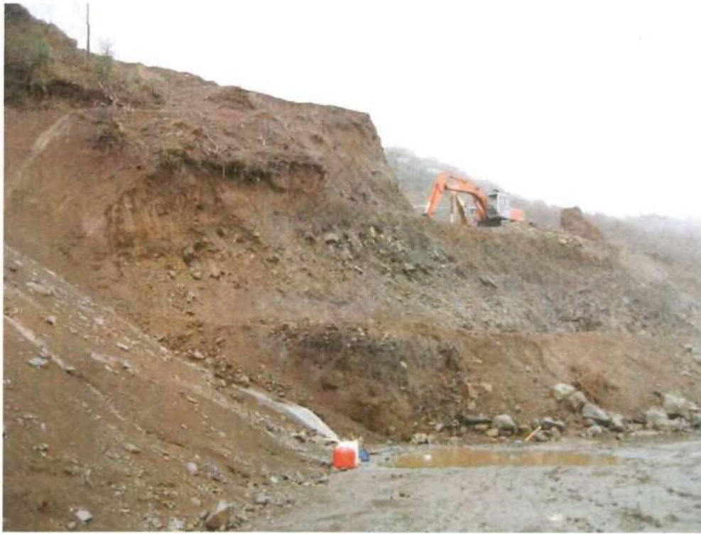
E工区からD工区を望む
