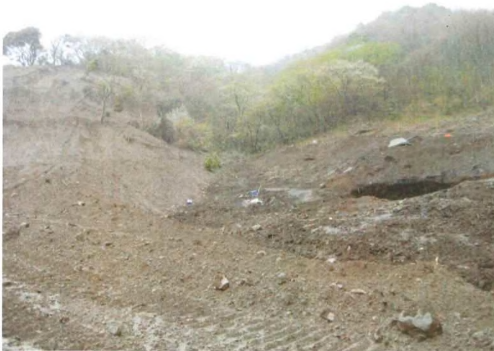
D工区上流側法面の状況
