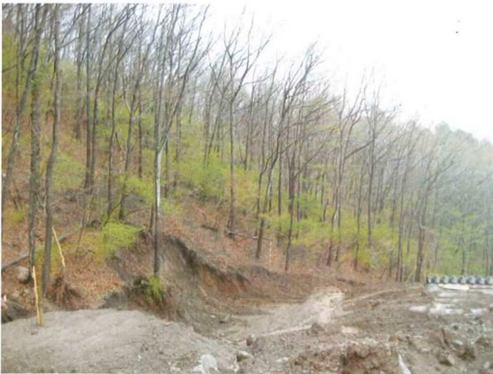
D 工区下流側の状況
