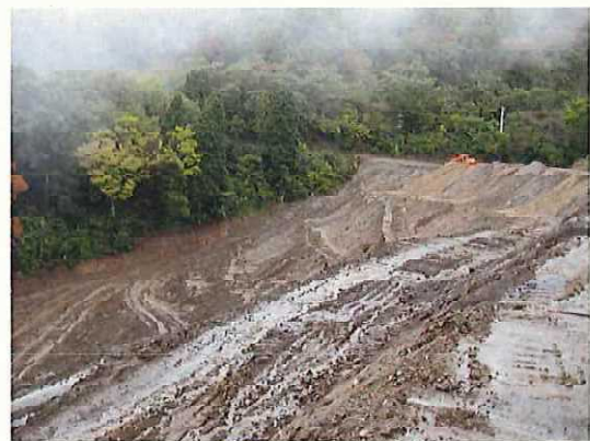
06法面状況(伊豆山土採取) 2009/11/11 10:34:44
