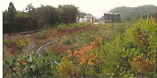
04取付道路遠景(伊豆山宅地分譲) 2009/11/11 10:23:18
