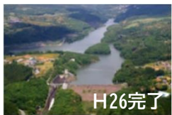
H26完了 防災ダムの整備 (浜松市都田川ダム地区)
