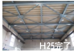
H25完了 排水機場(建屋)の補強 (伊豆の国市堂川地区)
