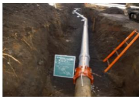
用水管補修（御殿場市）
