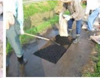
農道の部分補修
