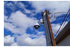
WEBカメラ設置 (富士市浮島排水機場)
