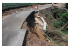
崩落した農道法面の復旧(牧之原市谷田地区)
