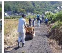
未舗装農道の舗装
