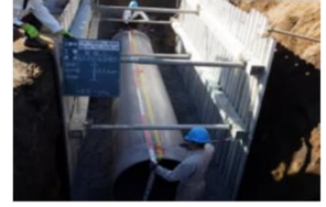
農業用水管改修（裾野市）
