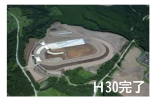
抜川調節池（小山町）
