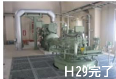
H29完了 排水機場の増設 (伊豆の国市毘沙門2期地区)
