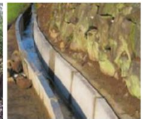
素掘り水路からの更新
