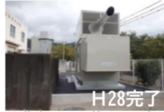
H28完了 非常用発電装置の更新 (函南町畑毛排水機場地区)
