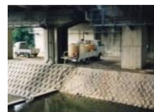
周辺河川より取水
