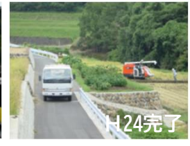
農道整備による大型機械の導入 (伊豆市中伊豆やすらぎ地区)
