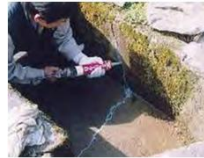
ひび割れの補修
