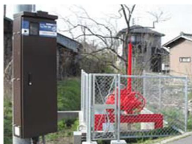
除塵機の設置
