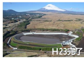
搦の木川調節池（裾野市）
