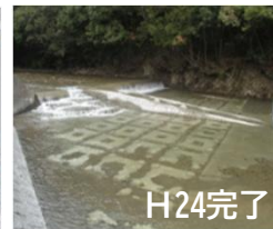
魚道の整備 (藤枝市滝沢地区)
