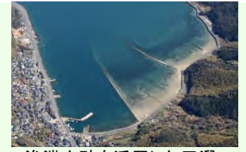
浚渫土砂を活用した干潟の造成(徳山下松港)
