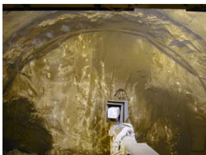
吹付コンクリートの施工例
