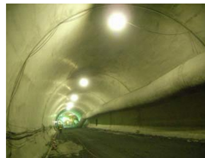
覆工コンクリートの施工例
