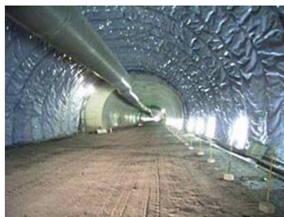
防水シートの施工例
