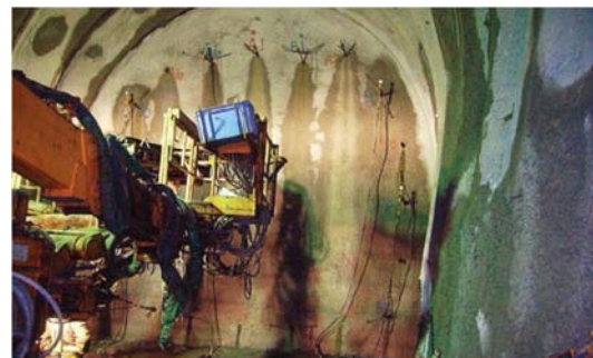
写真 薬液注入工の施工例
