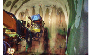
薬液注入の施工例
