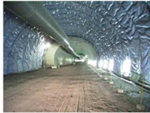
防水シートの施工例
