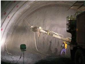
吹付コンクリートの施工例
