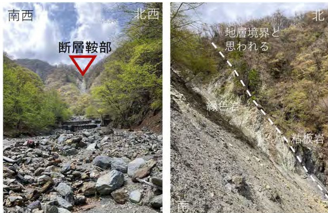
写真 3 調査 2 地点断層鞍部遠望と露頭状況
