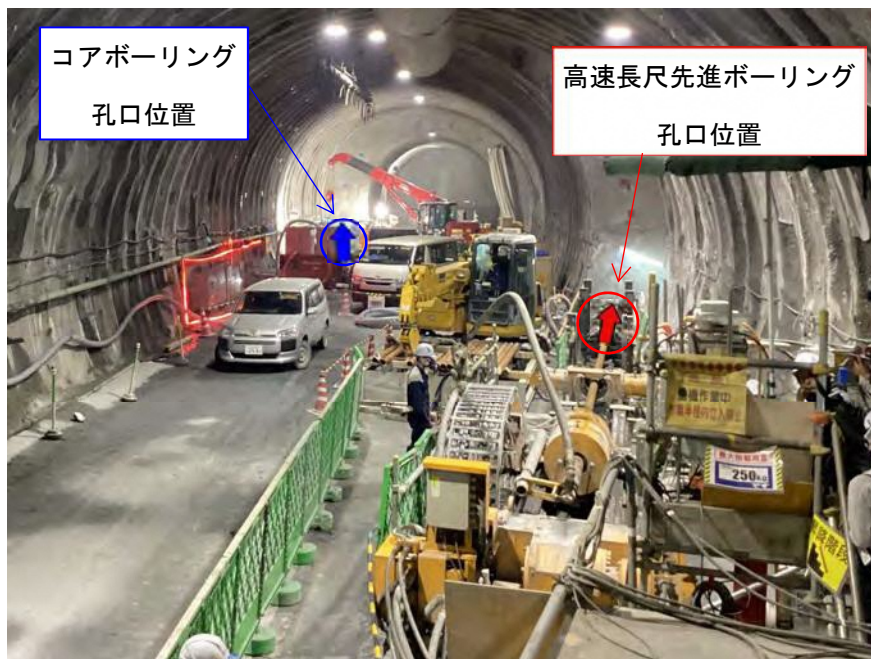
図 1 高速長尺先進ボーリングとコアボーリングの実施状況
