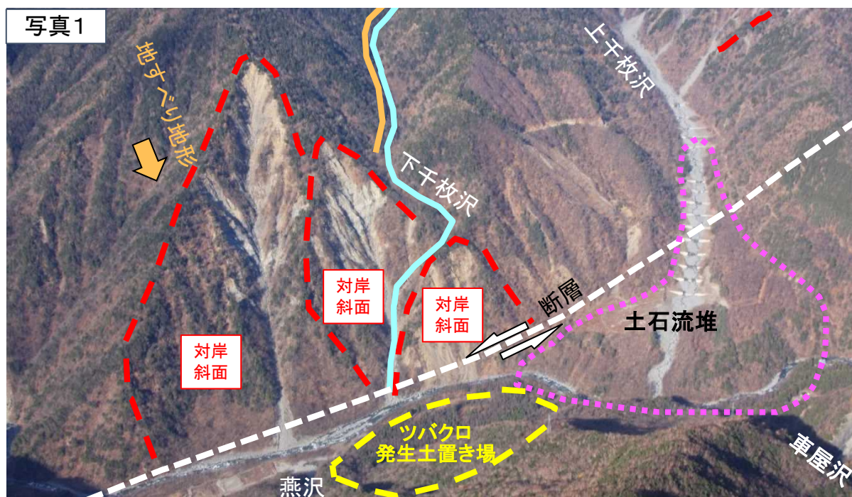
ツバクロ発生土置き場の西側の対岸斜面、上千枚沢の土石流堆
