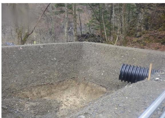
図 5 沈砂池の例
