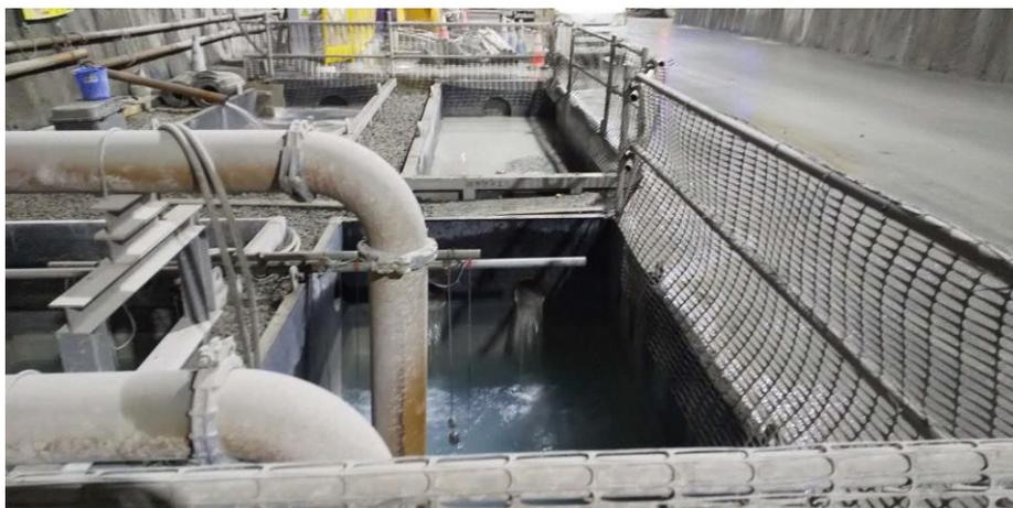
図 10 トンネル内の一時貯留設備のイメージ
