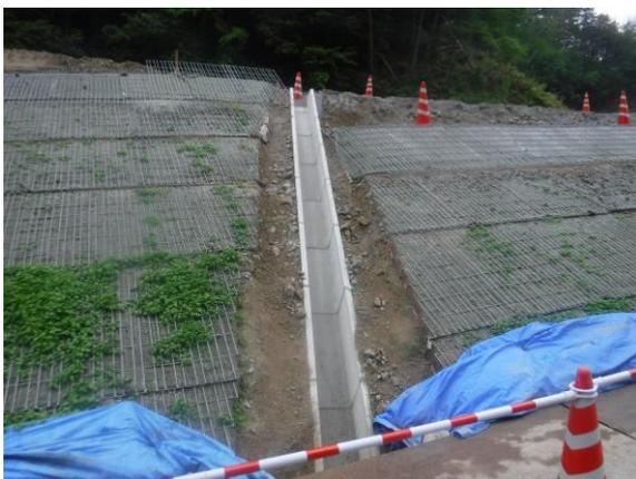
図12 盛土施工中の排水設備
