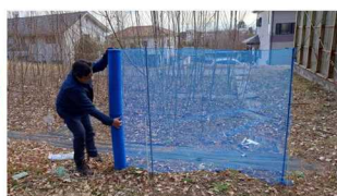
③防風ネットの設置
