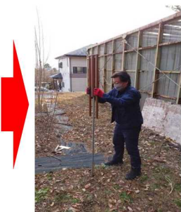
②直管パイプを打ち込む
