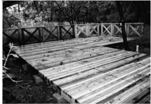
図1 デッキボードの設置状況
