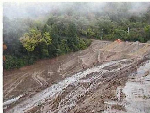
06法面状況(伊豆山土採取) 2009/11/11 10:34:44
