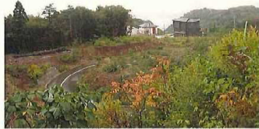
04取付道路遠景(伊豆山宅地分譲) 2009/11/11 10:23:18
