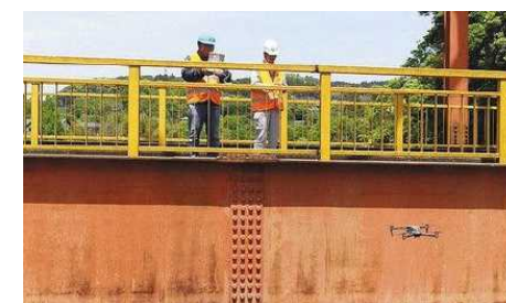
橋梁点検(千葉県君津市)※2
