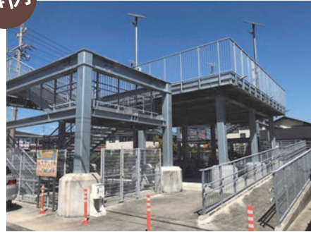
屋根・壁がない避難タワーの例
