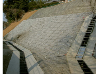
法面保護工の施工例
