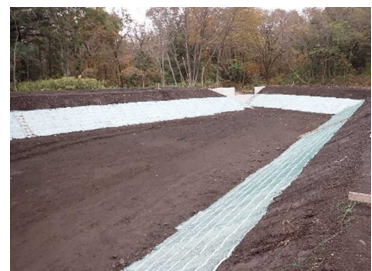
仮設防災調整池の設置例
