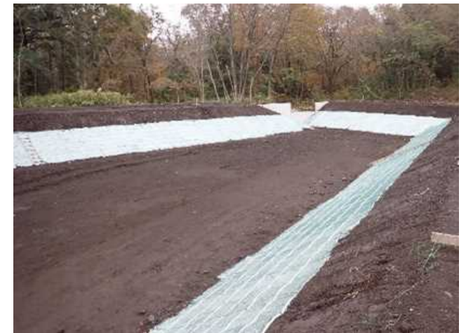
仮設防災調整池の設置例
