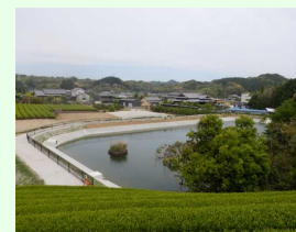
農業用ため池の防災・減災対策
