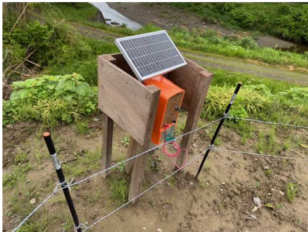
電気柵設置状況
