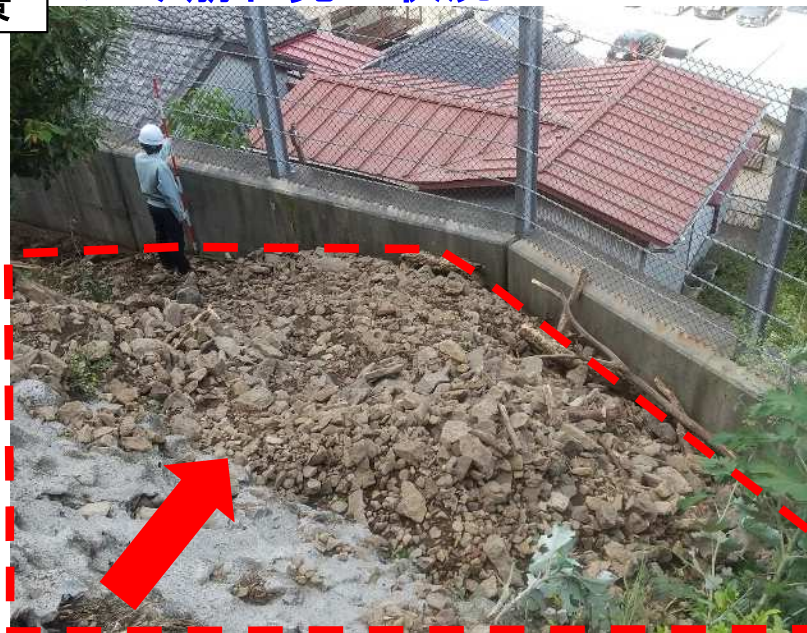
急傾斜地崩壊防止施設 (落石防護柵及び擁壁)
