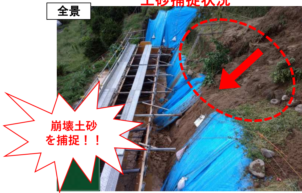
急傾斜地崩壊防止施設 (落石防護柵及び擁壁)
