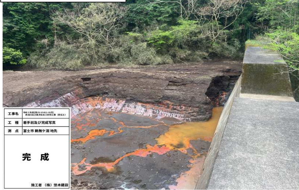
令和6年4月除石工事完成時
