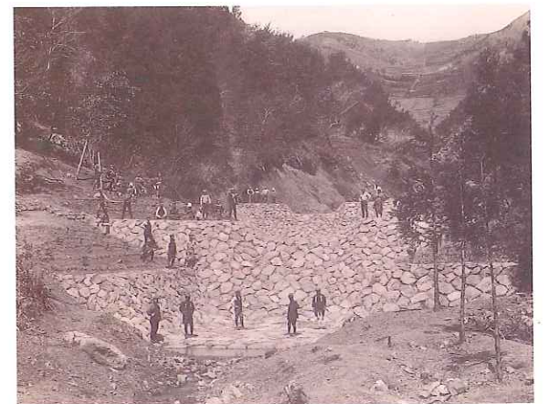
写真：明治44年度志太郡岡部町宇津ノ谷砂防工事撮影
