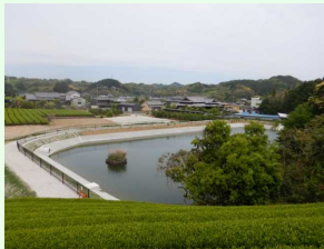
農業用ため池の防災・減災対策
