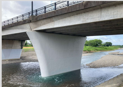
橋脚補強 (県道浜北袋井線 袋井市)
