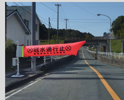
エア遮断機設置 (県道掛川天竜線 森町)
