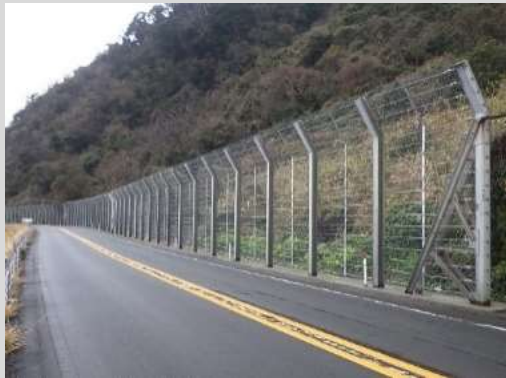
落石防護工 (国道135号 東伊豆町)
