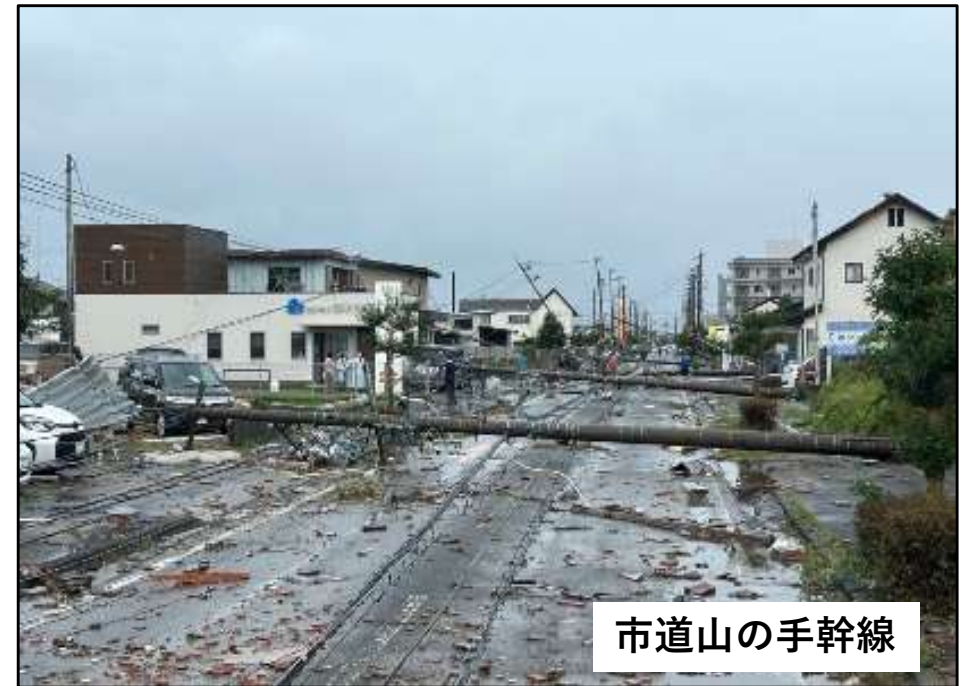
図一 2 竜巻により倒壊した電柱
