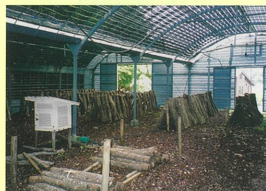
●ハウス型人工ほだ場内部
