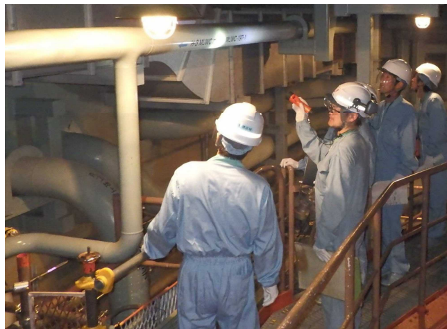
配管据付け状況の点検の様子
