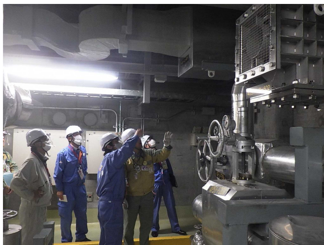
浸水防止ダンパ据付け状況の点検の様子
