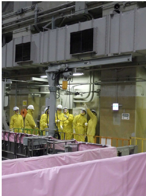
チャンネル取扱ブームの固縛状況の点検の様子
