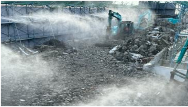
解体工事等での遠隔散水実施状況
