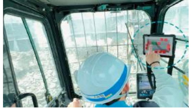
重機から散水ON/OFF(タブレットによる遠隔操作)
