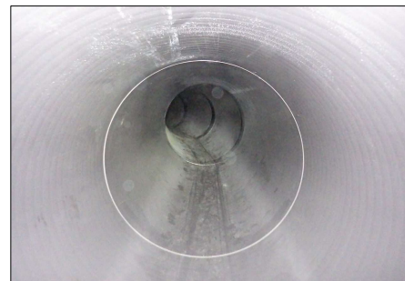
雨水管渠内部（内径1,800mm）
