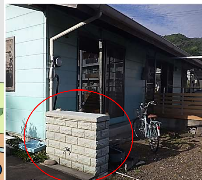
雨水貯留タンク設置事例
