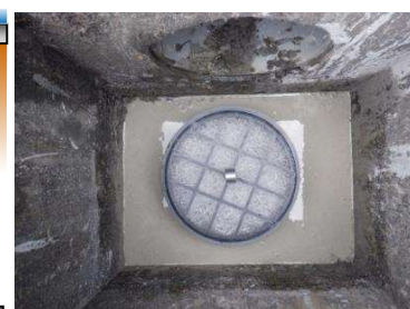
浸透管整備後の集水枳の内部
