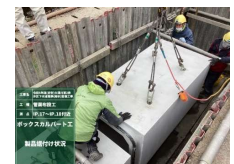
ボックスカルバート据付状況
