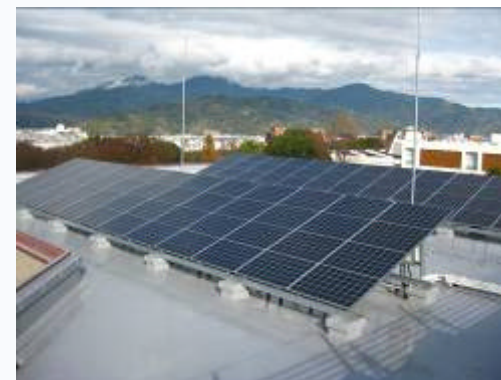
太陽光発電装置の設置(県立美術館)
